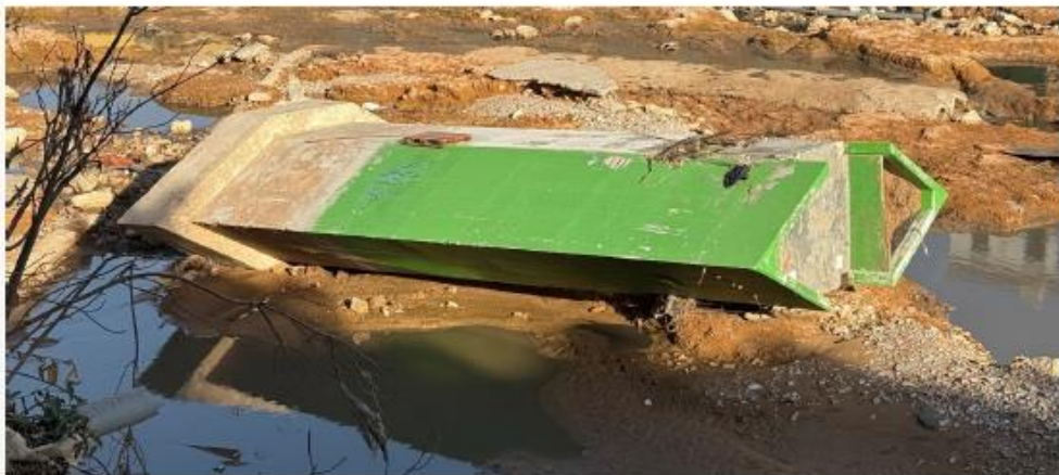
Pasarela de Almassereta (Picanya) (primera imagen anterior al 29/10/2024)
