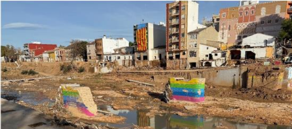
Puente de la calle Valencia (Picanya) (primera imagen anterior al 29/10/2024)
