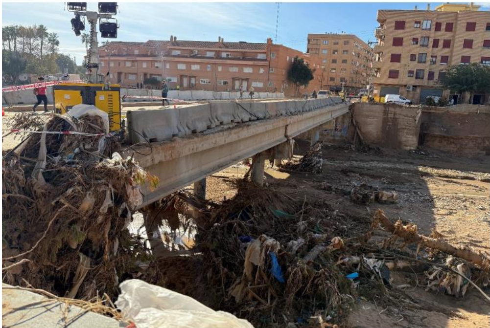
Pont Nou (Paiporta)
