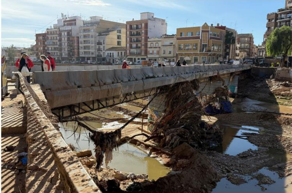
Puente de la calle Primero de Mayo (Paiporta)
