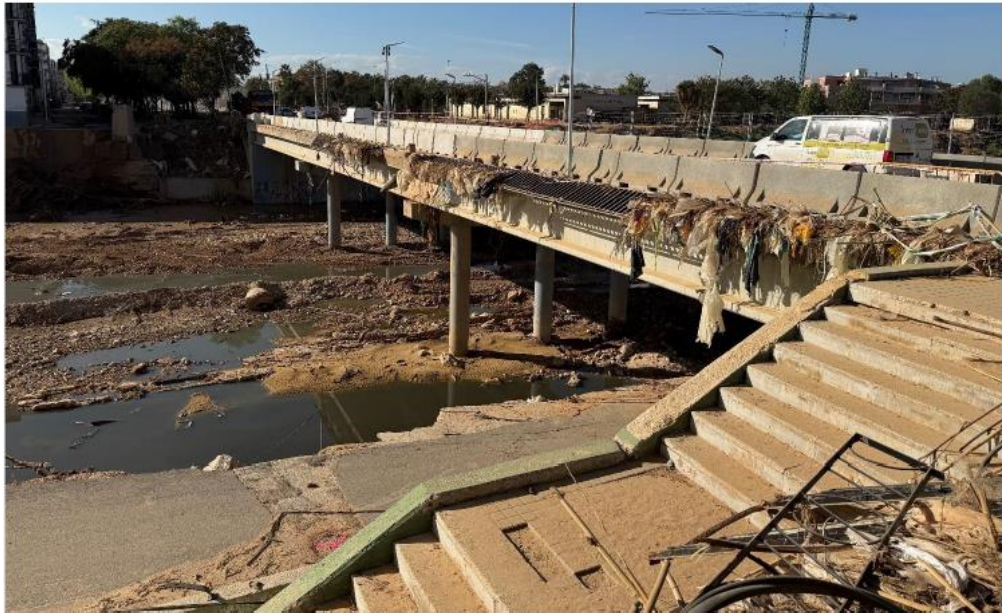
Puente de la carretera CV-406 (Paiporta)
