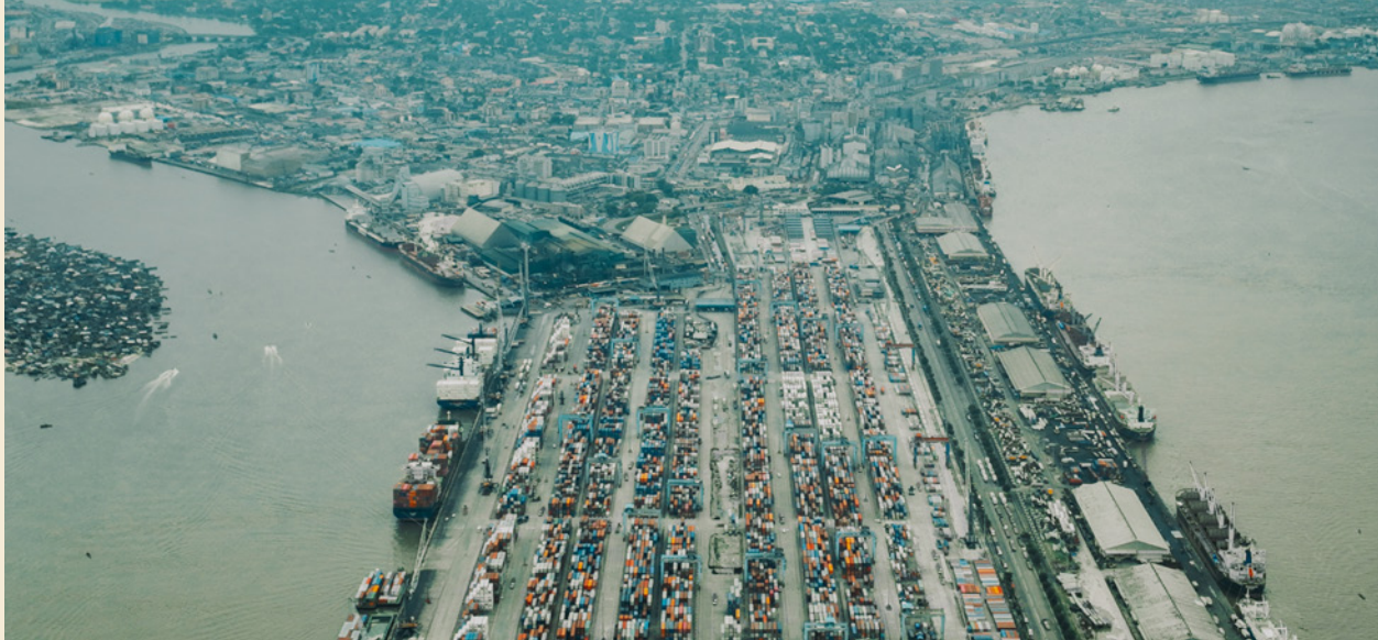
Port de Lagos, Nigeria.
