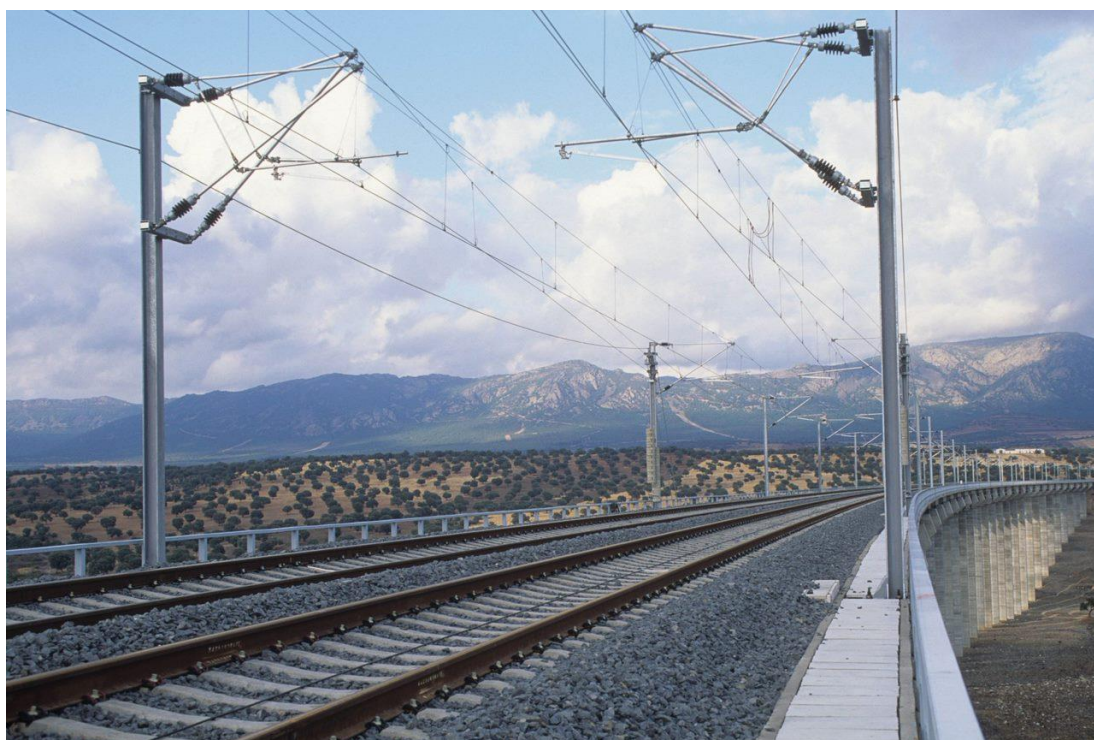
Tramo de la Línea de Alta Velocidad Madrid-Sevilla
